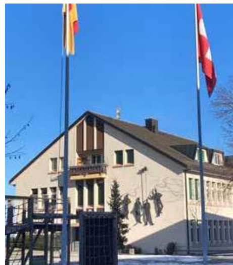
Sirene vorne auf dem Dach über dem Haaggeri-Saal in Samstagern.
